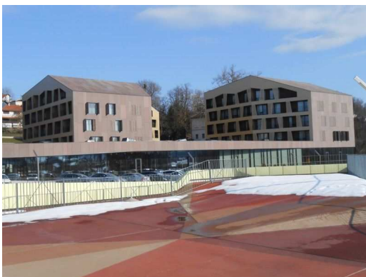
Der renovierte Teil mit den „Classic“-Zimmern
